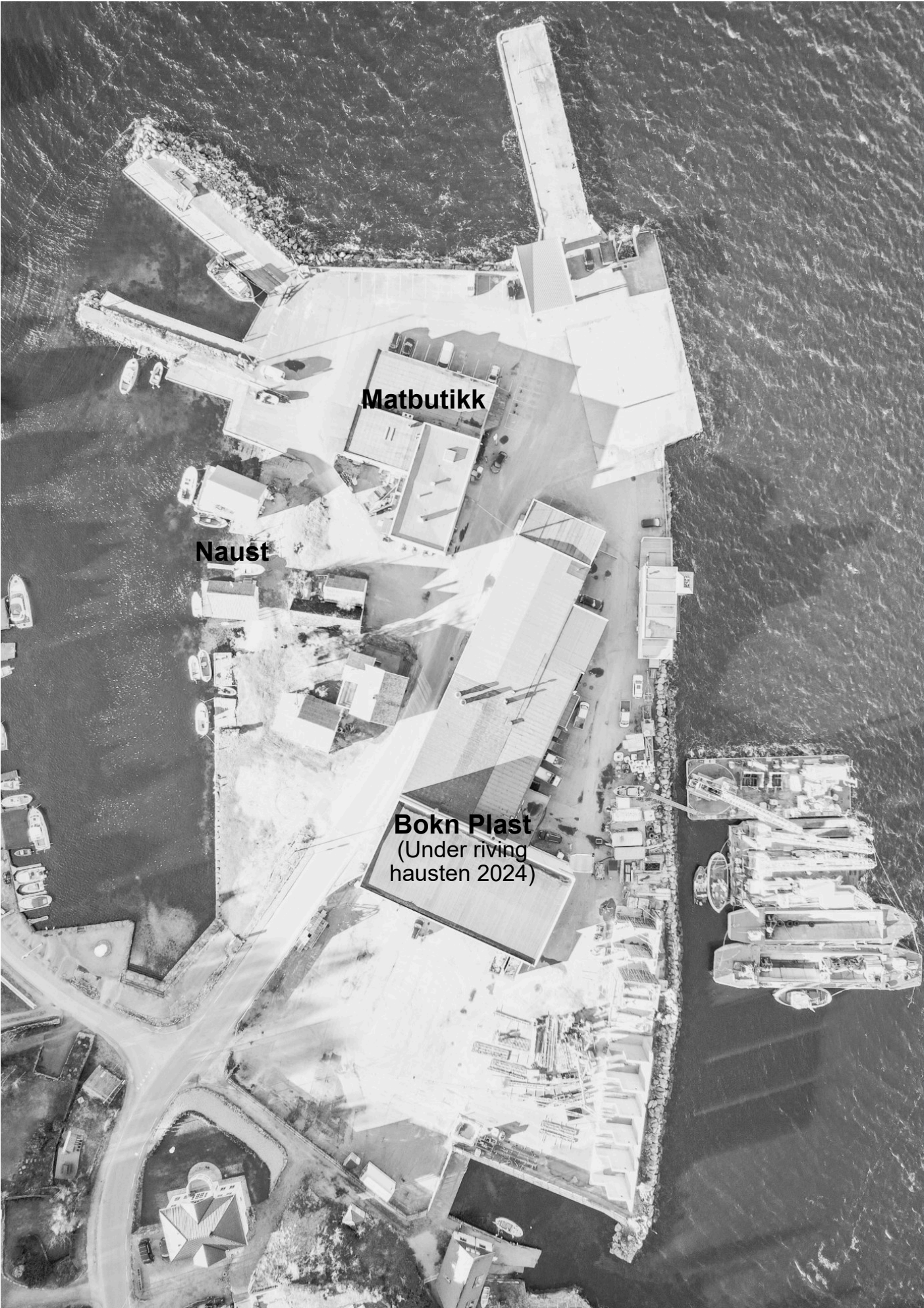
Situasjon på Gamle Holmen i Føresvik, datert før sommaren 2024. Arbeidet med å rive Bokn Plast pågår hausten 2024.
