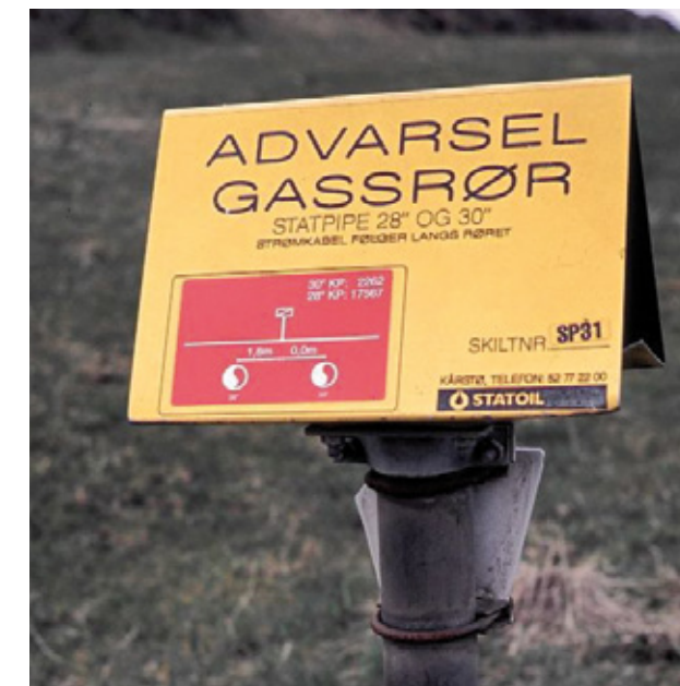
Merking av gassrør langs rørledningstraséen.
