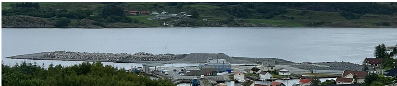
Figur 4 - Oversiktsbilde av Gamle og Nye Holmen frå juni 2025. Bokn Plast sitt bygg på Gamle Holmen er rive, og utfyllinga for Nye Holmen er komme langt, kjelde: Omega 365
