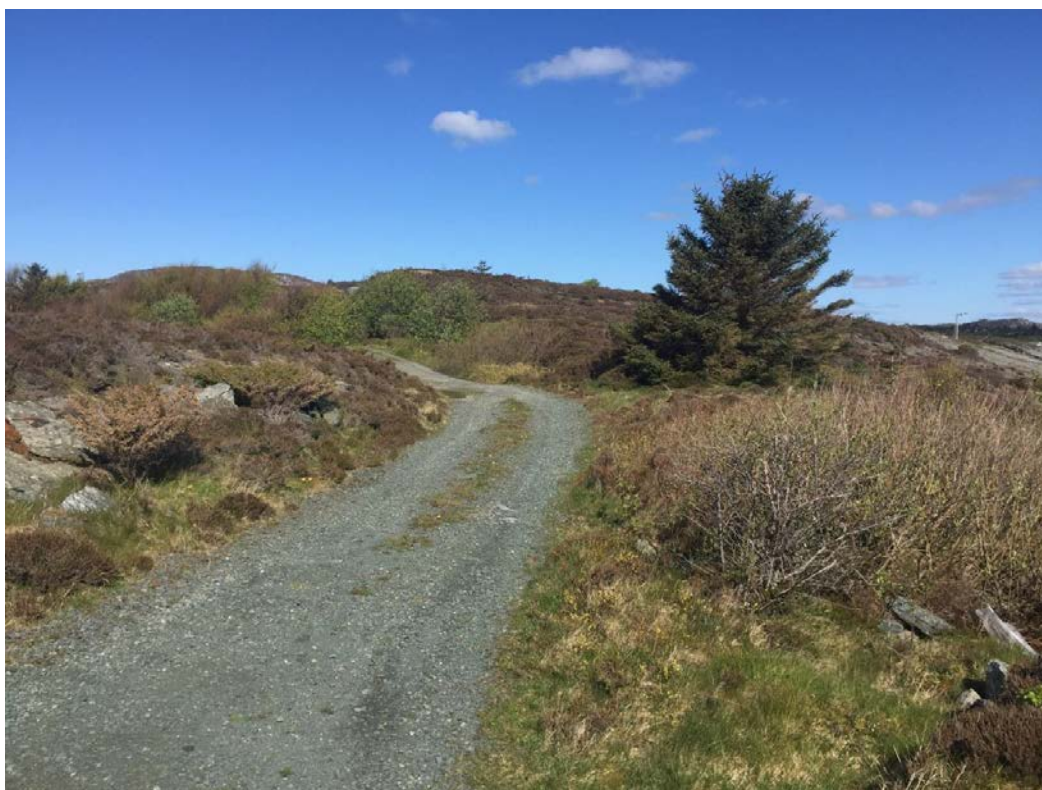
Fig. 7.10 Grusvegen over Laksaberget Foto: Torgeir Isdahl
