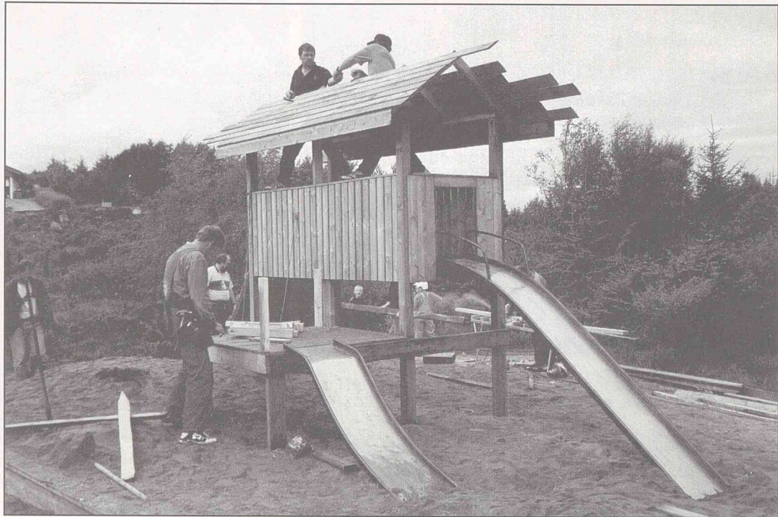
Inga ulempe med ein tømmermann i velforeninga, Leif Kjellesvik leiar arbeidet. På taket er brørne Rune og Trond Vatnaland. I bakgrunnen fv. Olav Rossebø og Svein Ivar Langhelle.
