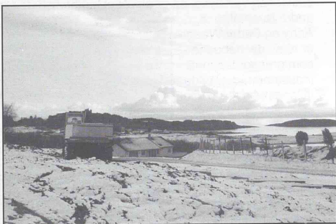
Ein gravemaskein står att i ledningstrasseen for at oppryddingsarbeidet etter grøftegravinga skal kunna utførast .
