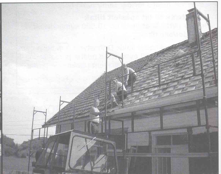
Her er dei i full gang med å rive bedrehuset på Hagland.
