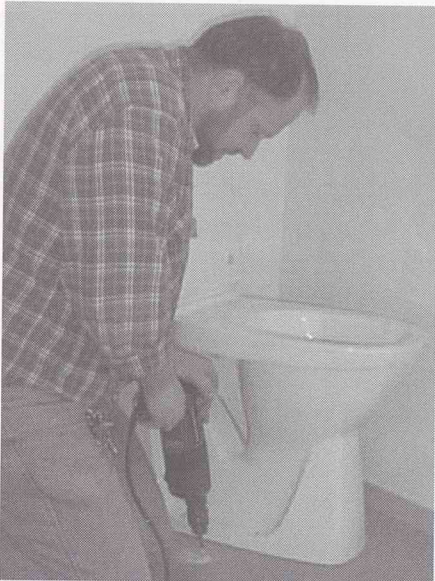
Egil Ognøy tar seg av toalett-arbeidet.
