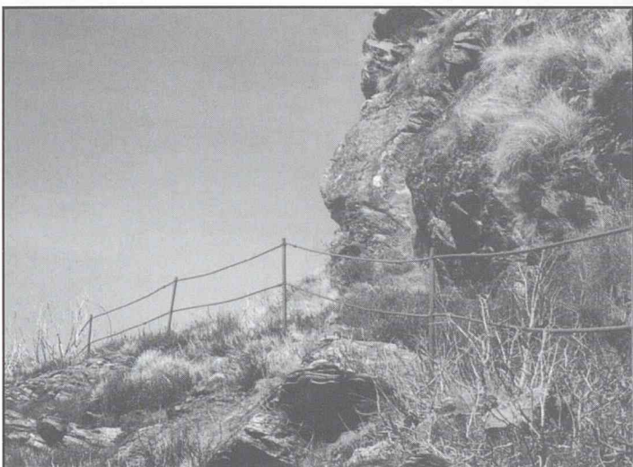
Langs den sør-vestre sida av Hognåsen går stien langs den bratte fjellskrenten som stuper mange meter ned mot sjøen. Her er det i ei lengd av rundt 25 m sett opp eit gjerde i jern for å sikra folk for å falla utfor skrenten.
