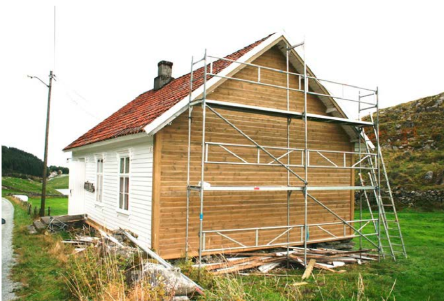
I september 2008 fekk sørveggen ny kledning, 100 år etter at huset var nytt.
