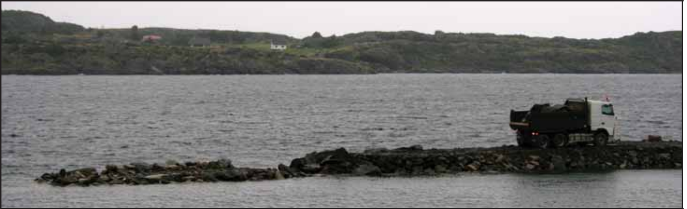
31.08.2009: Eksisterande molo blir heva og utsida plastra.
