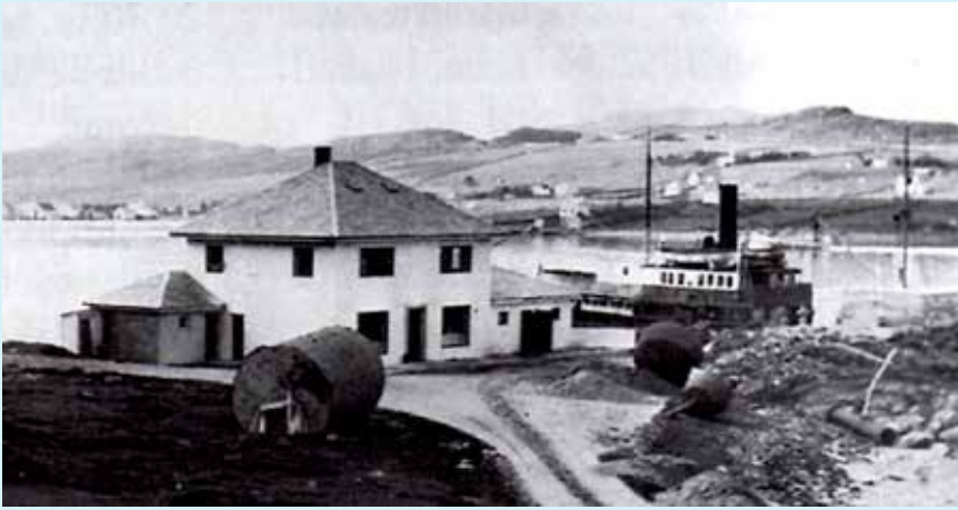
DS Sandeid til kai i Tåganes bare nokre månadar før havariet.
