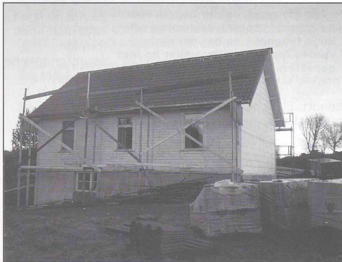
Det nye taket ble bra!
