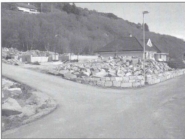
Neste grunnmur for hus på Øyrenfeltet ligg klar for byggearbeidet.
