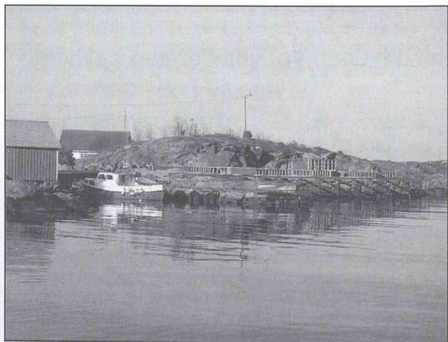
I dette området er det ei større hytte under oppføring, og ein murkant til sjøen. Stein som var lagt utanfor murkanten er fjerna. Det er påbegynt eit arbeid med jernbjelkar utanfor murkanten som ser ut som påbegynt kai.
