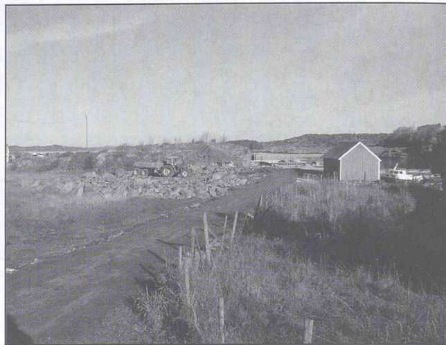
Ved enden av vegen er arbeidet påbegynt med ei av dei 2 hyttene som nå skal byggjast. Til venstre der traktoren står, er det lagt ei steinfylling i søyla.
