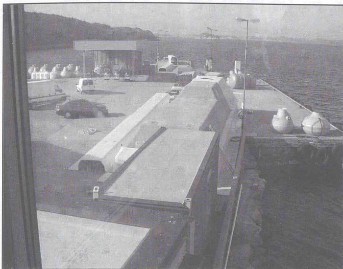
Konstruksjonene til oljeindustrien er relativt stor, og viser godt igjen rundt Bokn Plast i Føresvik.
