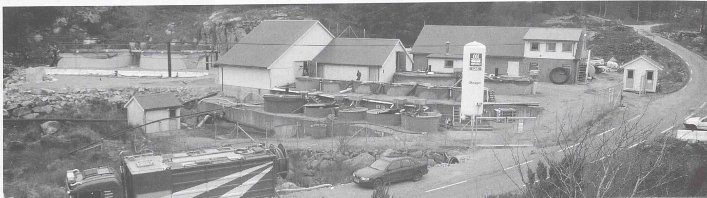
Oversiktsbilde over settefiskanlegget på Trosnavåg. Oksygentanken stikk opp i været i forgrunnen. Til venstre nye kar.
