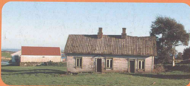
Huset som skulle brennast, sett frå vegen. Den gamle taksteinen er tatt ned. Bildet er knipsa ei kort stund før huset vart påtent.
