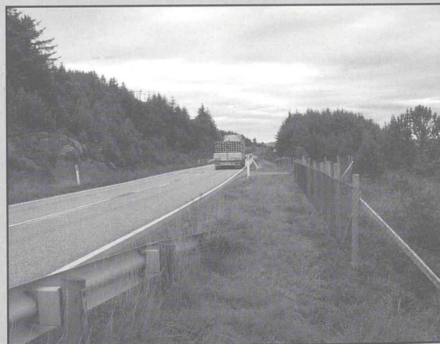
Det nye gjerdet langs E-39 over byggefeltet ved Hålandssjøen.
