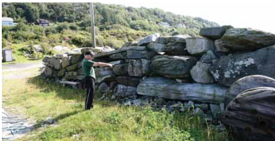
Å få brygga til å liggja, har vore ein evig kamp mot elementa. Ikkje før lødde dei ei ny brygge, så kom sydvesten og raserte heile greia. For å få brygga til å liggja, henta dei jamvel steinar frå det store kaianlegget i hamna nord på Nordre Vågaholmen.
